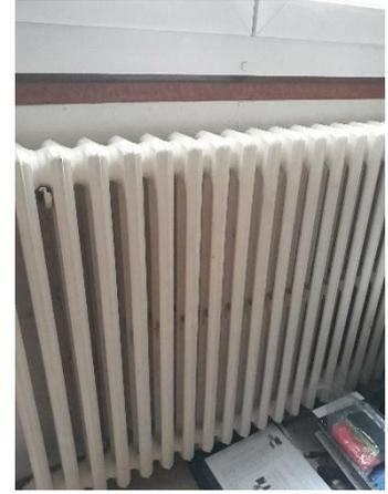
Bien comprendre que l'on perd toujours 1000 Watts à travers le mur !
